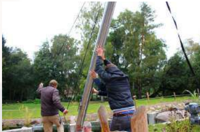
Aufstellung von Stützmasten
